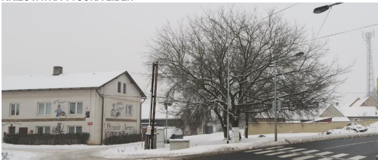
Foto č. 27: celkový pohled na řešenou lokalitu (leden 2017)
