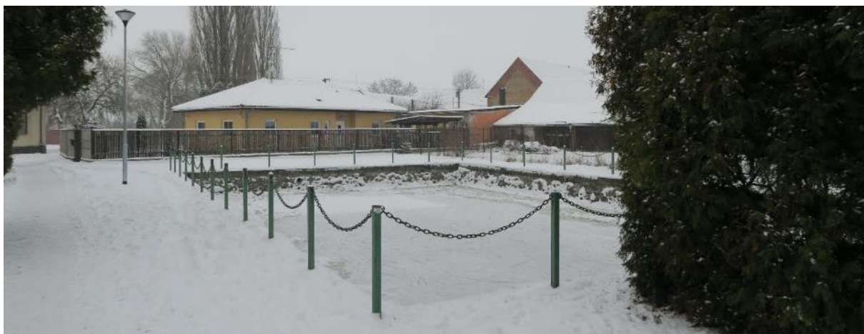
Foto č. 10: pohled na vodní nádrž na návsi se stavebně upraveným břehem (leden 2017)
